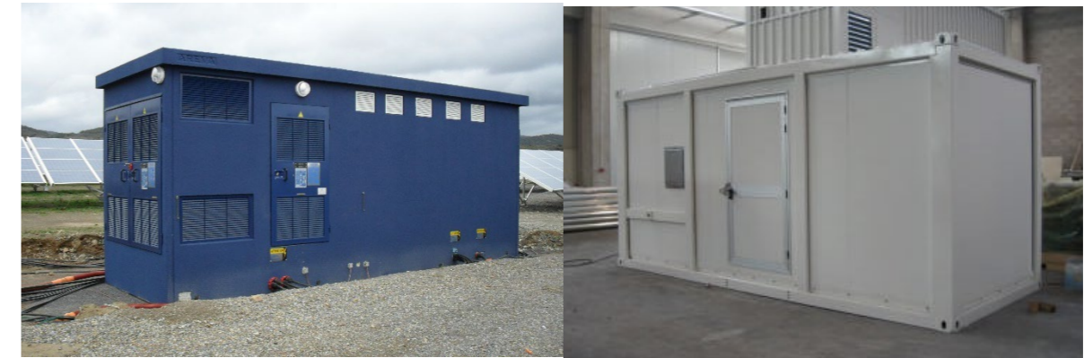
Exemples d'onduleurs et transformateur installés dans des postes béton et containers
