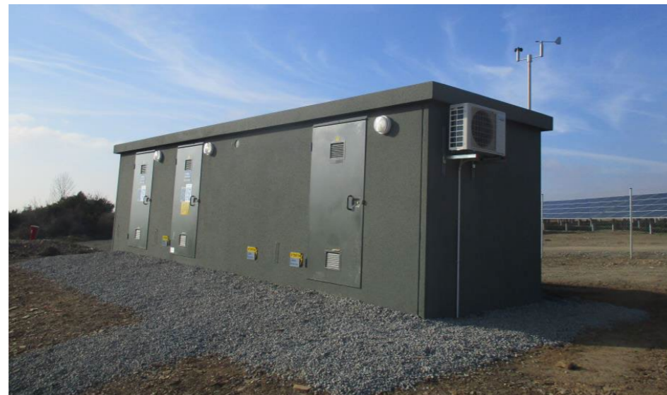
Figure 10 : Exemple de structure de livraison (Source : RES)
