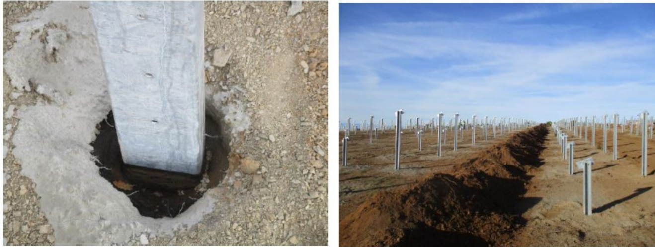
Exemple de fondation type pieux
